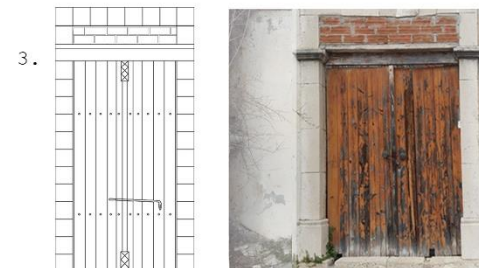
Ξανιδωτή δίφυλλη εξώθυρα με περιθύρωμα από πελέκητη πέτρα και υπέρθυρο, με φεγγίτη στο άνω μέρος που έκλεισε μεταγενέστερα - Εξωτερική όψη
